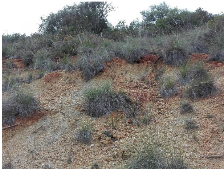
Figura 3.28. Deslizamento superficial, aspeto de pormenor
